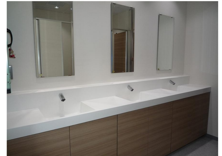
改修後は洗面器一体型ツインデッキカウンターを採用。上部棚をドライエリアとして使えるため、ディスプレイにも適している。
