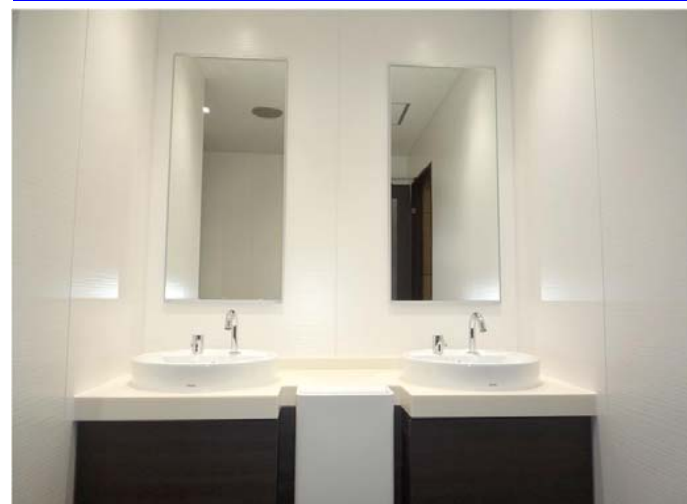
ベッセルタイプの丸型洗面器とカウンター埋め込み式のハンドドライヤーで使いやすさと床への水漏れの軽減に配慮。発電タイプの自動水栓により、停電時でも水が使えるようにしている。
