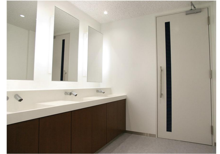
発電タイプの自動水栓とすることで停電時の利用も可能。水石けん入れも非接触で使用できるものを採用した。
