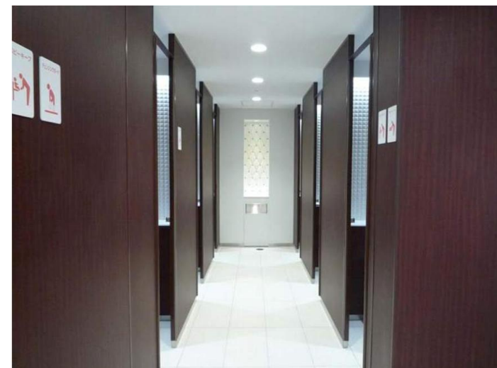
大便器ブースの扉には、「パニックオープン機能付」の戸当りを採用。通常は内開きの扉が緊急時には外開きとなり、容易に救出することができる。
