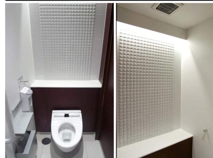
大便器はデザイン性の高いRESTROOM ITEM 01を採用。間接照明の光が、タイル張りの壁を立体的に浮かび上がらせる。
