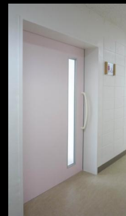
建具 部活などで手が塞がっていても肩で開けられるハンドルに。
