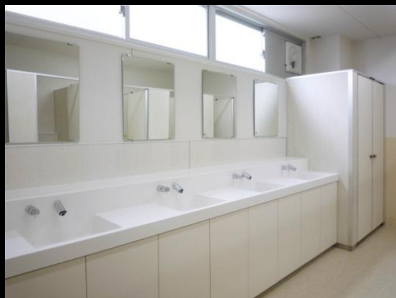
女子トイレ 上方吐水のツインデッキカウンターに、自動水栓。奥のブースは両開き扉で、中には掃除流しを設置。
