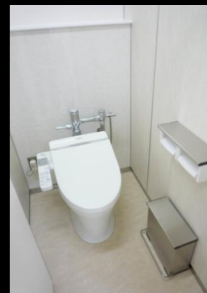
大便器 和風便器を洋風にし、ウォシュレットを設置。
