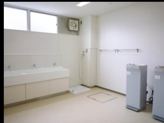
水飲み場 人工大理石の流しを設置し、ウォータークーラーを新設。また、洗濯機が置けるようバンを置いた。
