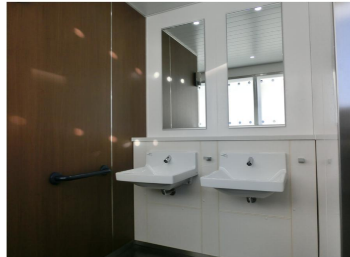
既設のカウンタータイプから壁掛ハイバック洗面器への改修により省スペース化、洗面まわりの動作空間を確保している。洗面器横には傘などをかけるフックを設置。
