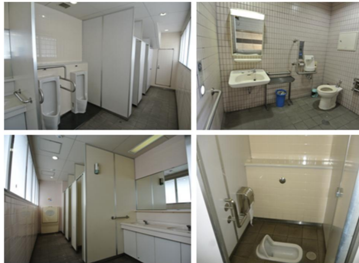
完成から16年経過し、より多くのお客様に快適に駅をご利用頂くために、トイレのリニューアルを行いイメージアップを図る検討を行った。
