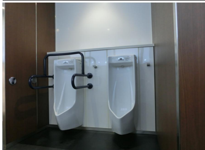
床の清掃性や節水性に優れた壁掛式低リップタイプの小便器を採用。足元には尿の飛散などに配慮した清掃性の高いハイドロセラ・フロアPUを設置している。
