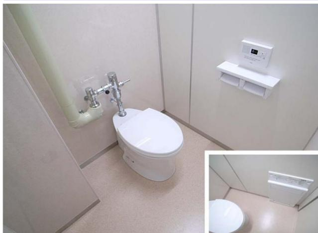
給水管が露出した大便器ブース。トイレで着替える女子生徒が多いため、すべての大便器ブースにフィッティングボードを設置。女子生徒に好評な2度流しを防止する音姫(擬音装置)も完備している。
