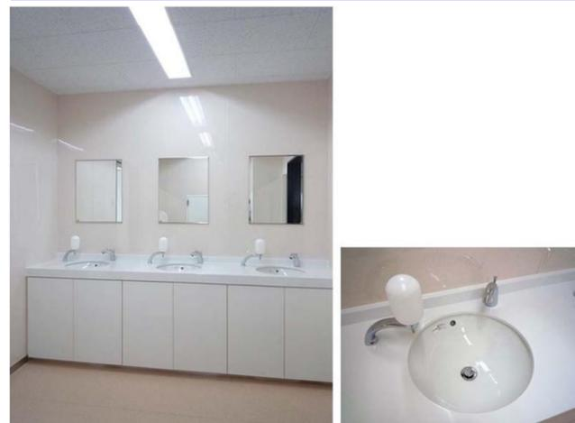
水栓金具は感染対策として、ノンタッチで水の出し止めができる自動水栓を採用。カウンター下は、ペーパーなどのストックができるように収納スペースとなっている。
