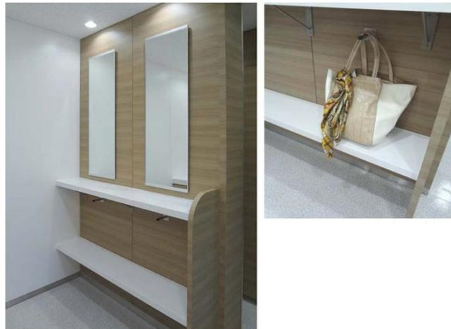
隣の人の視線が気にならないように個別鏡を採用。9号館と同様、荷物配慮として900mmと400mmの高さに2段式の棚とフックを設置。
