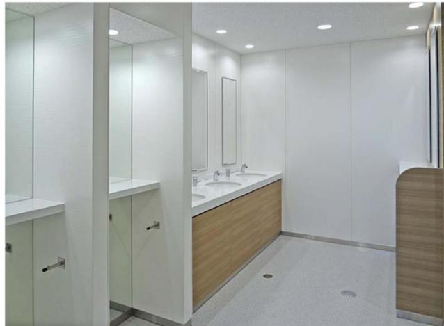
9号館と同様、ノンタッチで水の出止めができる自動水栓と水石けん入れを採用。洗面コーナーの対面と左横にパウダーコーナーを設置。
