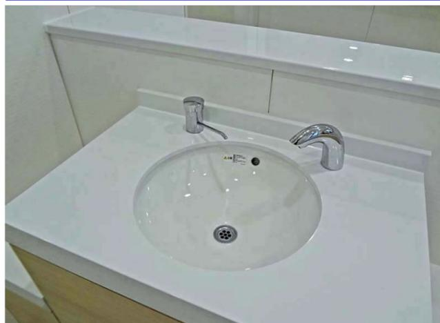
ノンタッチで水の出し止めができる自動水栓と水石けん入れを採用。衛生面の向上とともに、節水効果も図れる。
