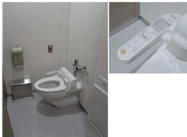
2度流しを防止するために音姫(擬音装置)機能を搭載したウォシュレットをすべてのブースに採用。また、着替えもできるフィッティングボードを2ヶ所のブースに設置している。
