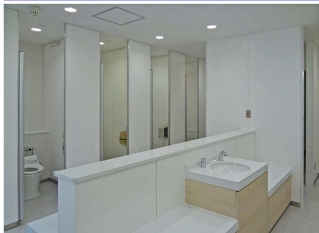
洗面コーナーと大便器コーナーの間の壁をなくして、開放感のあるトイレ空間に一新。洗面器の両サイドにはベンチとしても利用できる荷物棚を設置している。
