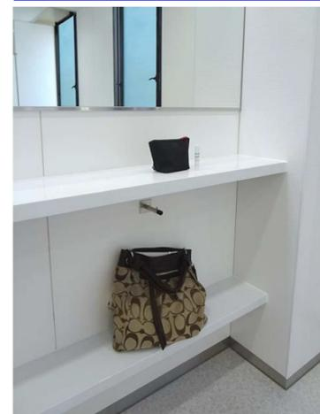
化粧ポーチや荷物を置くことができる2段式の棚とフックを設置。鏡に近づいてお化粧直しができるように、棚の奥行きは上段250mm、下段200mmと浅くしている。
