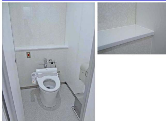
環境に配慮して6L洗浄のパブリックリモデル便器を採用し、すべてにウォシュレットを設置。奥行き200mmのライニング上部は荷物棚として利用できる。
